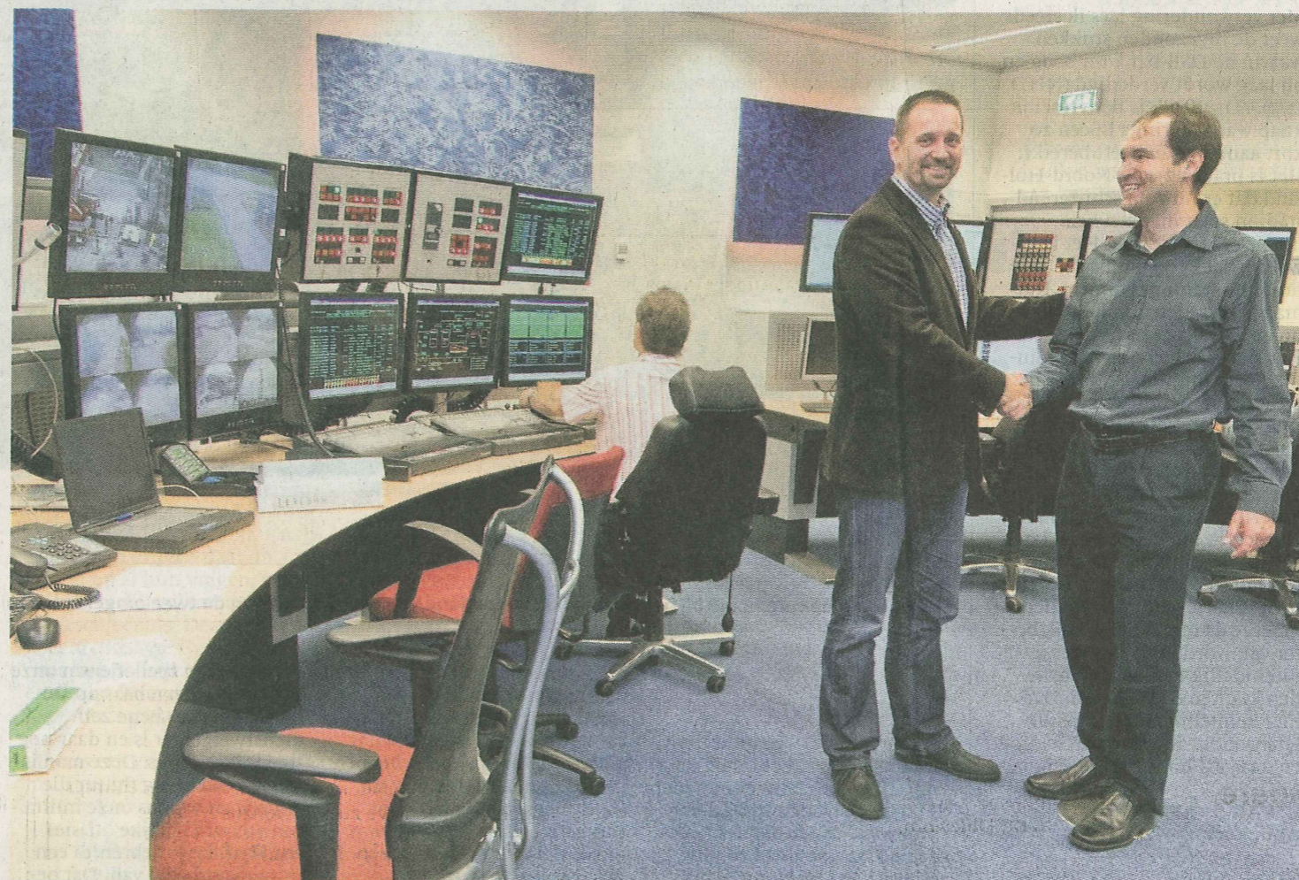
Wilms (links) en Müller in de centrale controlekamer van de NAM-gasbehandelingsinstallatie.
